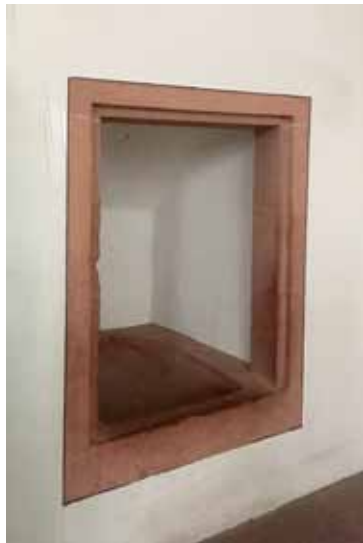
„Speibecken“ im südlichen Erdgeschoss-Saal des Ruprechtsbaus, vermutlich ein Spülbecken der im 17. Jahrhundert hier untergebrachten Schlosswache.
